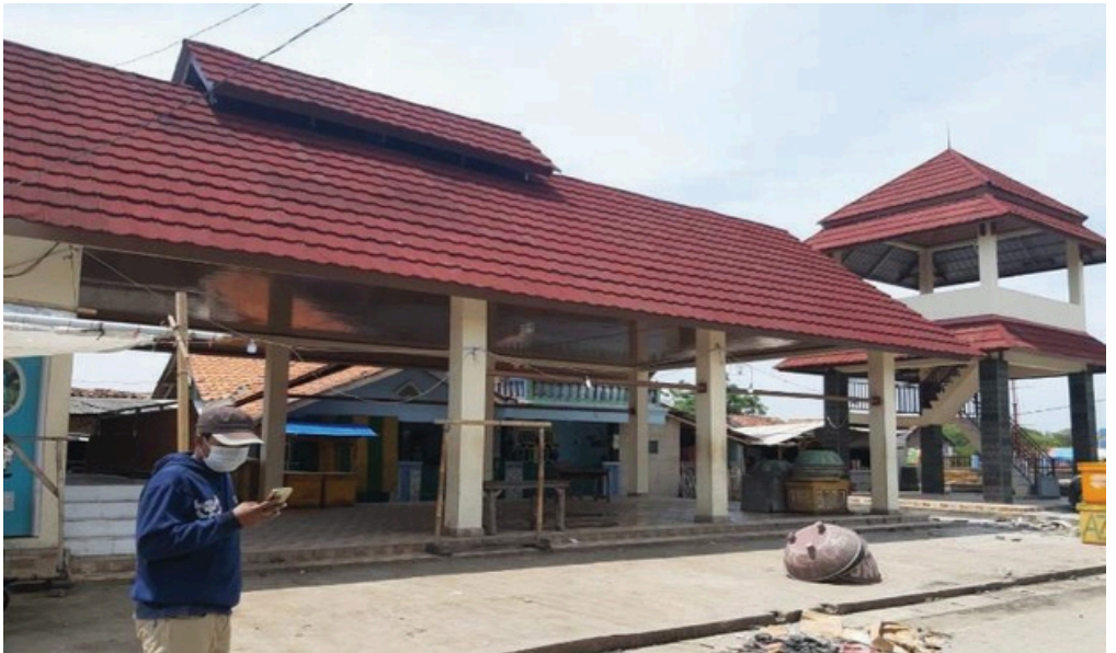
KETAPANG, PEDESTRIAN GEDUNG TPI - SESUDAH
