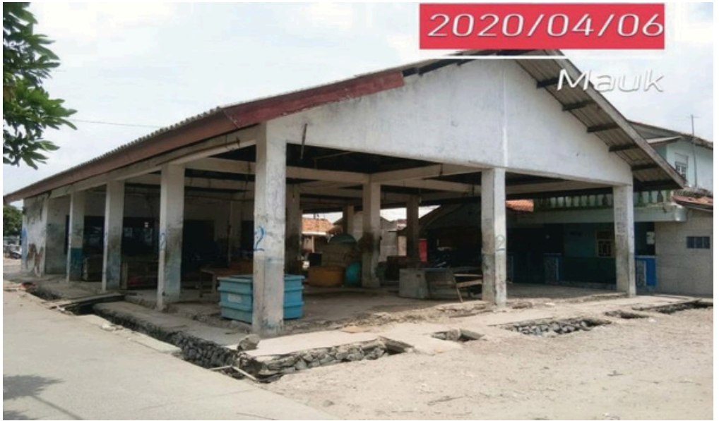
KETAPANG, PEDESTRIAN GEDUNG TPI - SEBELUM
